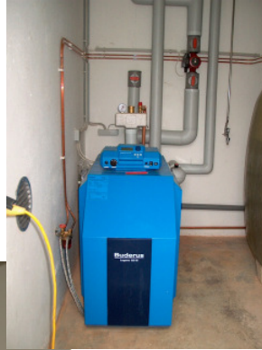
Niedertemperatur- Öl-Kessel 45 kW
