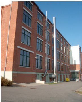
doppelwandiger Edelstahl- Abluftkamin für Küchenabluft
