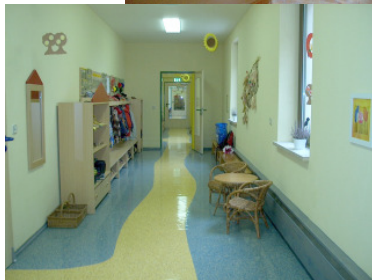
Sockelleistenheizung und Thermohorizontalsperre
