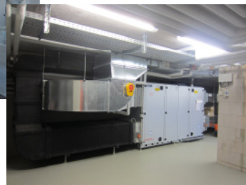
Be- und Entlüftungsanlagen mit Wärmerückgewinnung
