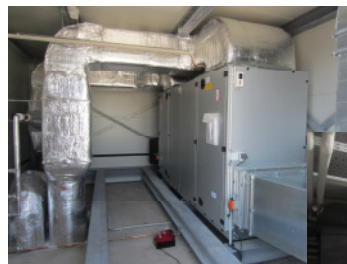
Be- und Entlüftungsanlagen mit Wärmerückgewinnung
