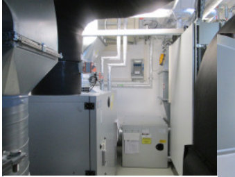
Be- u. Entlüftungsgerät mit Wärme rückgewinnung und Nachkühler
