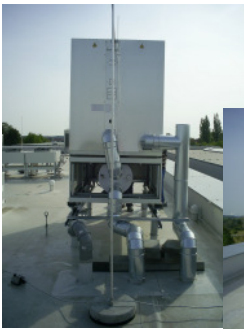
Luft-Wasser- Wärmepumpe
