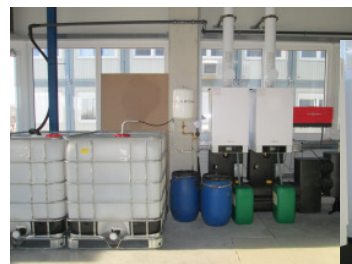
Gas-Brennwert- Mehrkesselanlage 210 kW für Wärmeversorgung der Pulverbeschichtungsanlage
