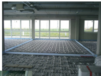
Fußbodenheiz- u. kühl system mit Pyramiden- wärmeleitblechen
