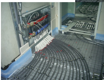
Fußbodenheiz- u. kühl system mit Pyramiden- wärmeleitblechen
