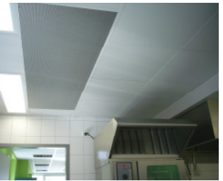
Küchenlüftung mit Induktions- ablufthaube und Küchen- zuluftquellauslässen
