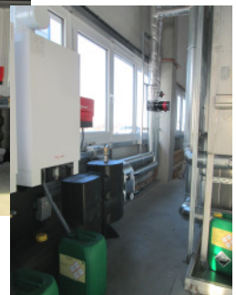
Gas-Brennwert- Mehrkesselanlage 210 kW für Wärmeversorgung der Pulverbeschichtungsanlage
