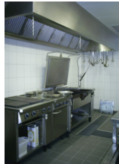
Küchenlüftung mit Induktions- ablufthaube und Küchen- zuluftquellauslässen
