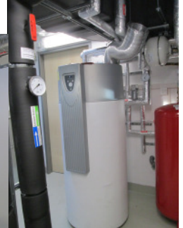
Trinkwasserwärmepumpe
